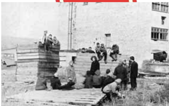
Весна 1965 г. На строительстве Института физики
