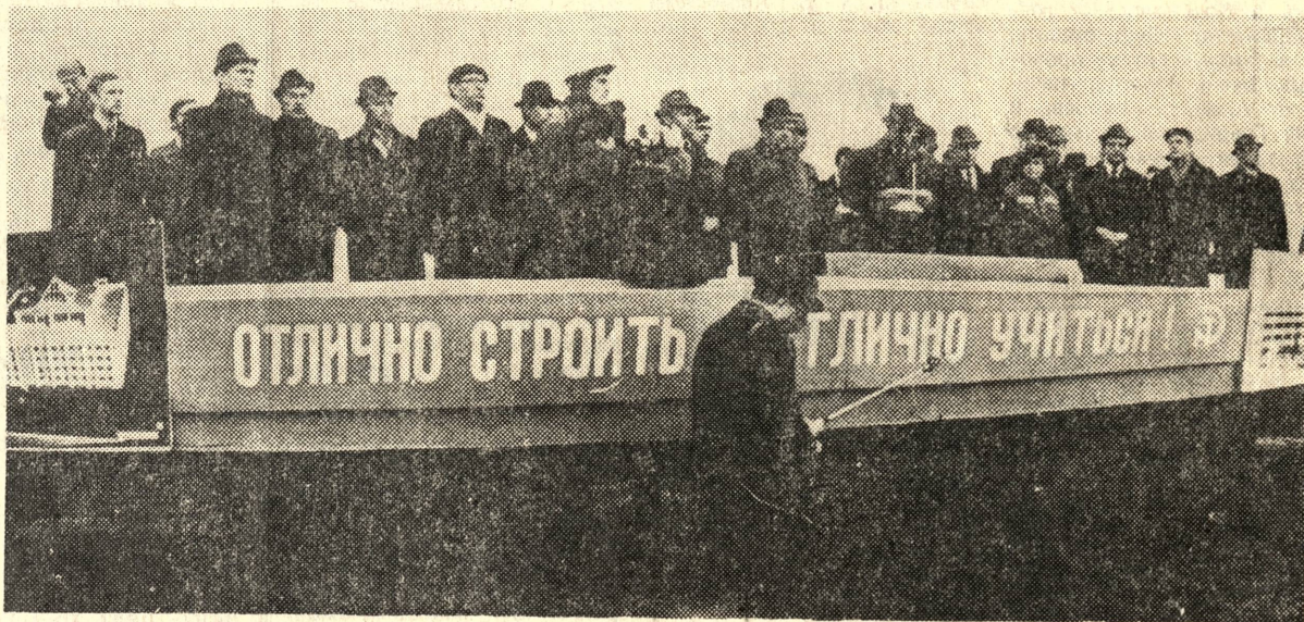
НА СНИМКАХ: Начало строительства в 1977 г. нового университетского комплекса.
