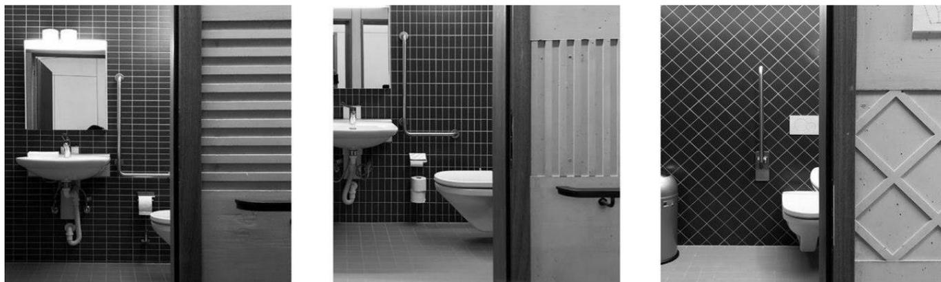
Рис. 3. Тактильная разметка в доме для слепоглухих [8]
