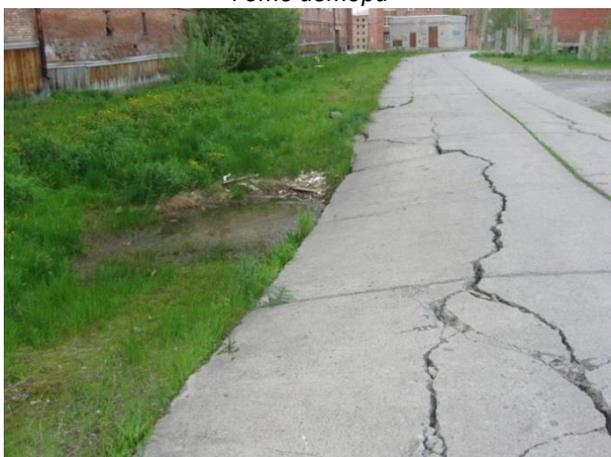
Рис. 3. Нарушение дорожного полотна морозобойными
