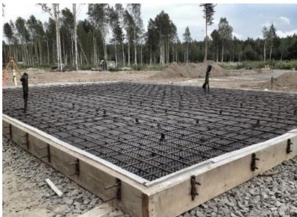
Рис. 2. Плитный фундамент [8]
