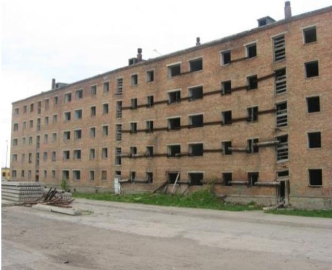
Рис. 5. Аварийное состояние дома, вызванное протаиванием многолетней мерзлоты и проседанием грунта под центральной частью здания [6]
