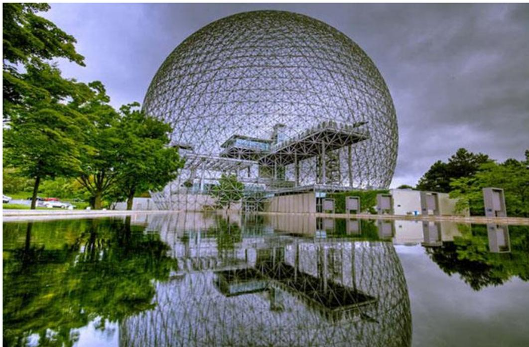
Рис. 2. Павильон США «Экспо-67» в Монреале на основе геодезической сферы Р. Б. Фуллера [5]
