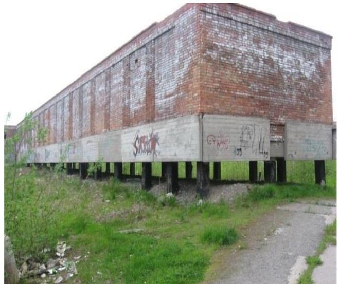
Рис. 6. Использование 1-го принципа строительства – вмораживание свай и создание вентилируемых подполий. Строящееся здание новой школы в Игарке. Фото автора
