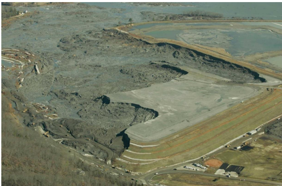
Рис. Вытекание золошлаковых отходов с загрязнением прилегающей территории
