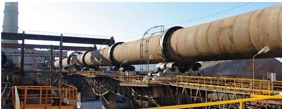
Рисунок 1 - Трубчатая вращающаяся печь на территории АГК
