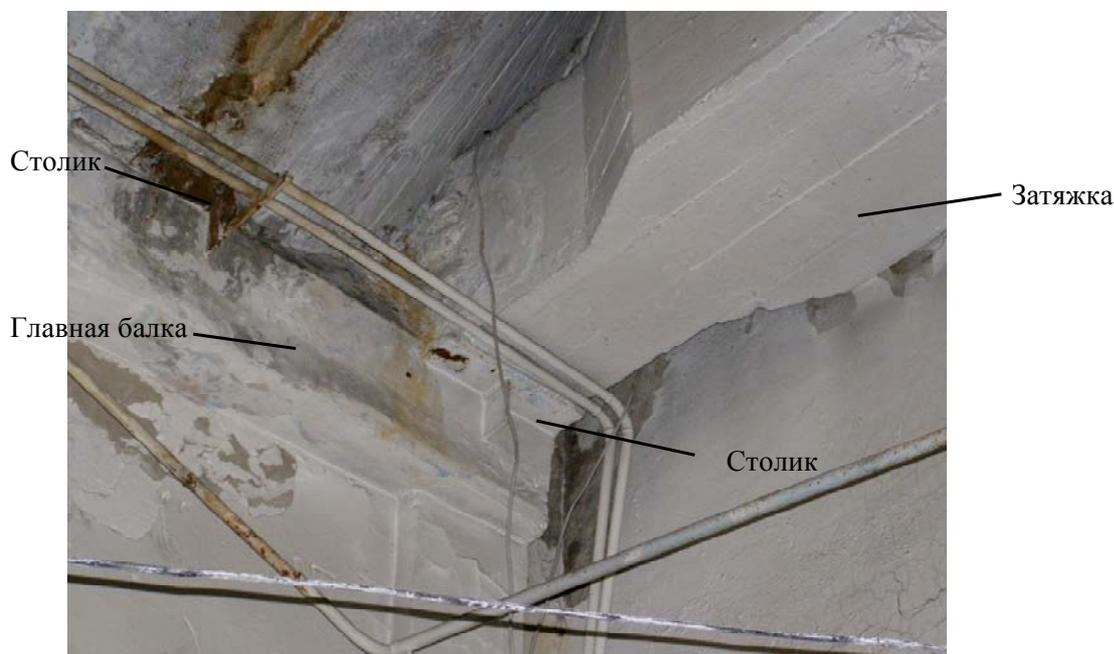
Рис. 7. Конструкция сопряжения волн оболочки и затяжки с главной балкой (вид затяжки в осях Г-Д, 3)
