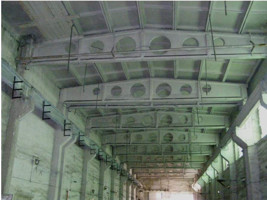
*Рис. 5. Конструкция покрытия бывшего склада готовой продукции (вид от оси О, 1-2)*
