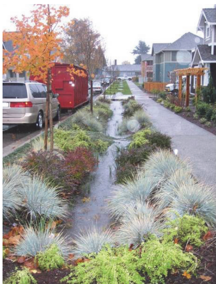
Рис. 2. Сбор и очищение поверхностного стока в Сиэтле, США [3]
