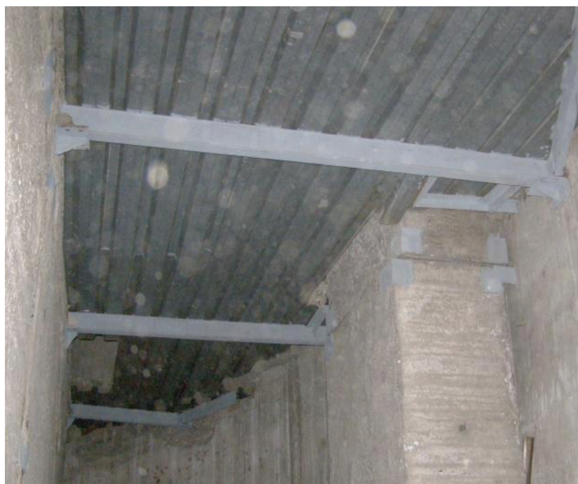
Рис. 6. Устройство перекрытия ядра жесткости
