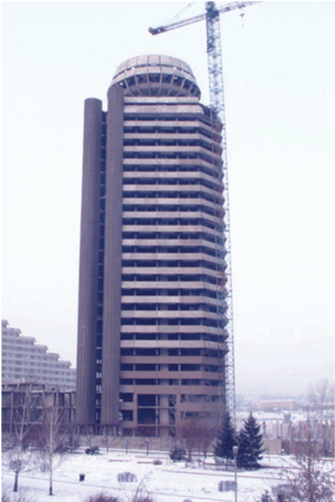
Рис. 3. Общий вид здания со стороны р. Енисей
