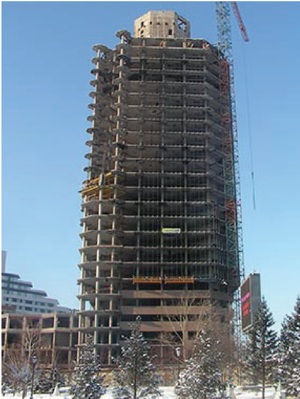
Рис. 9. Вид здания в момент начальной стадии переделки
