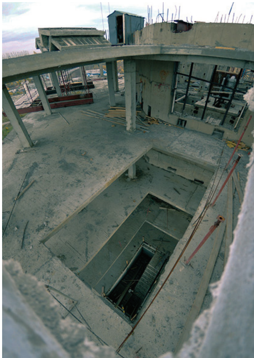
Рис. 7. Вид лестничных клеток и ядра жесткости в процессе их монтажа
