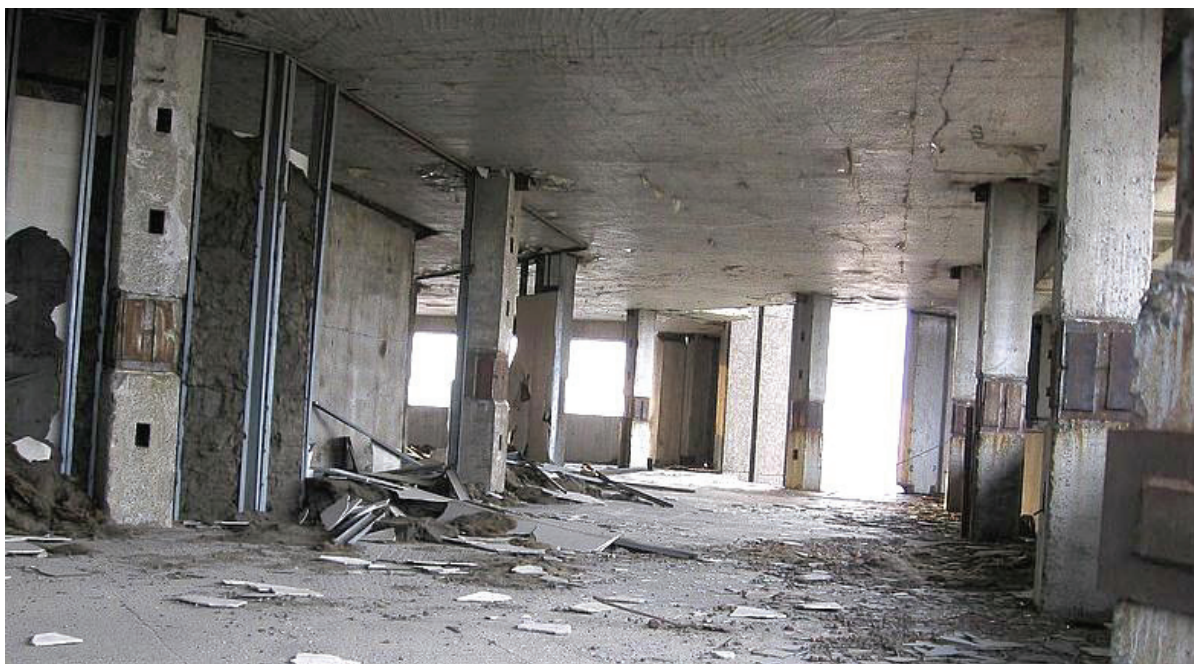
Рис. 4. Вид колонн на этаже
