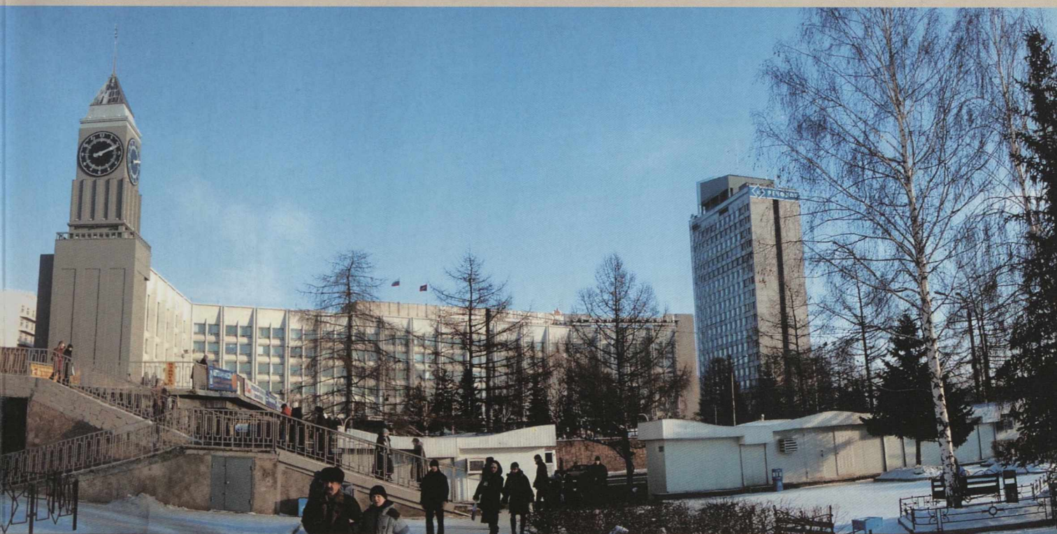
Реконструкция часовой башни здания городской администрации Красноярска. Соавтор: А.А. Пилипенко. 1998-2001
