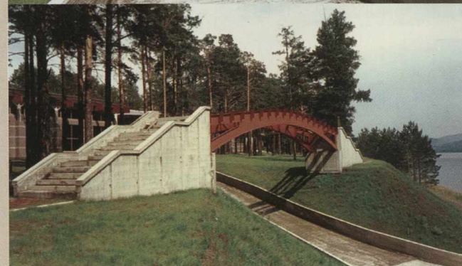
Благоустройство загородного комплекса «Сосны». 2000-2003
