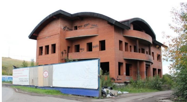
Рис. 1. Недостроенное здание в районе ул. Северонисейской
