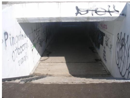
Рис. 4. Подземный переход на набережной реки Камы
