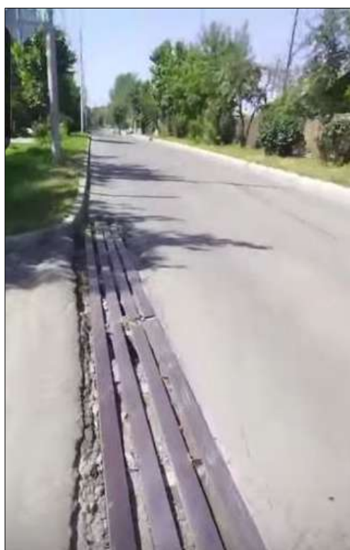
Рис. 5: а – отремонтированная дорога на ул. 60 лет Октября с решётками для водоотведения; б – ливневая канализация на ул. Степана Разина
