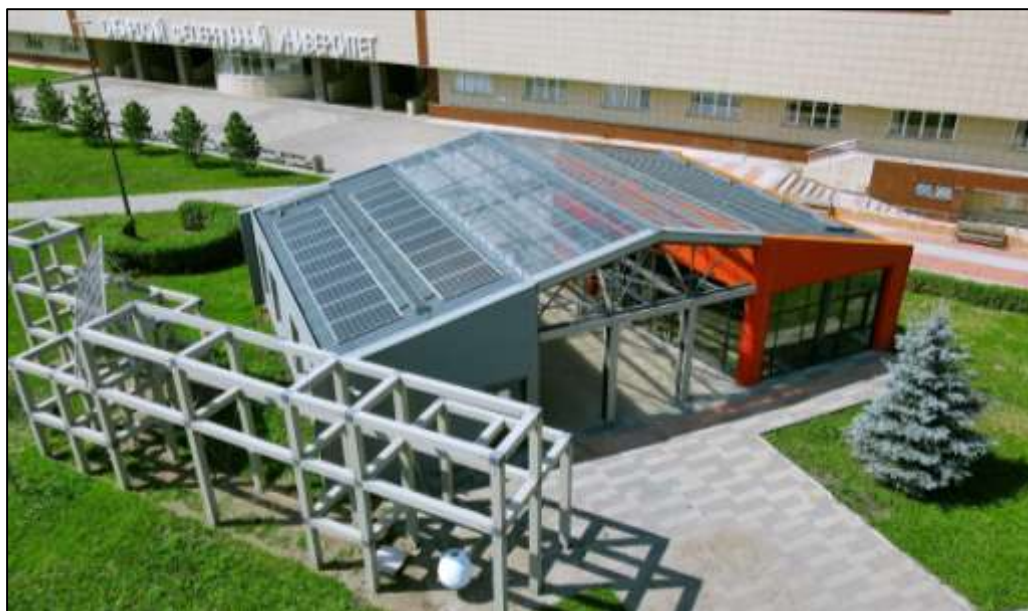
Рис. 1. Вид на установленные солнечные панели
