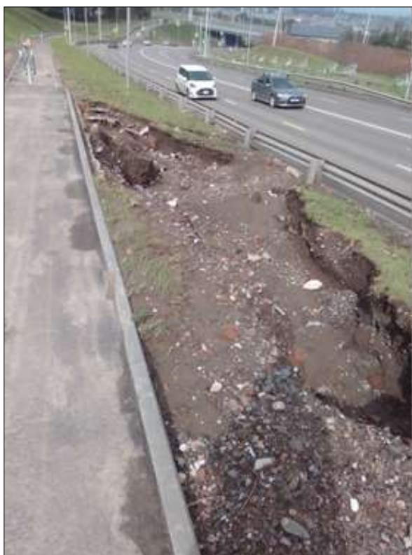
Рис. 1. Разрушение: a – откосов земляного полотна на Николаевском пр.; б – асфальтобетонного покрытия на прилегающей улице. Июль 2024 г.
