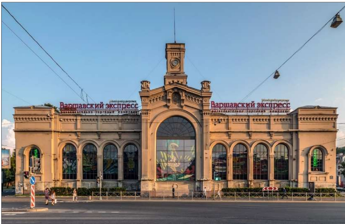
Рис. 2. Фасад Варшавского вокзала
