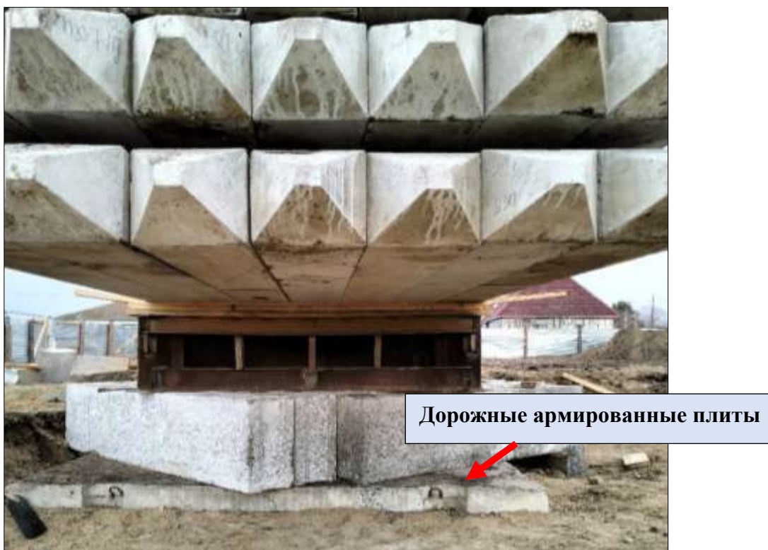
Рис. 4. Вид установки испытаний с использованием дорожных плит
