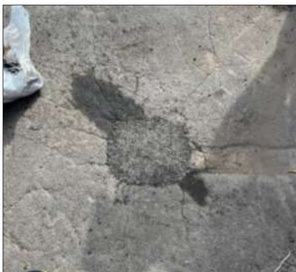
Рис. 5. Состояние ремонтной зоны сразу после ремонта 10.09.24 ( a ) и через 1 мес. после ремонта 09.10.24 ( б )
