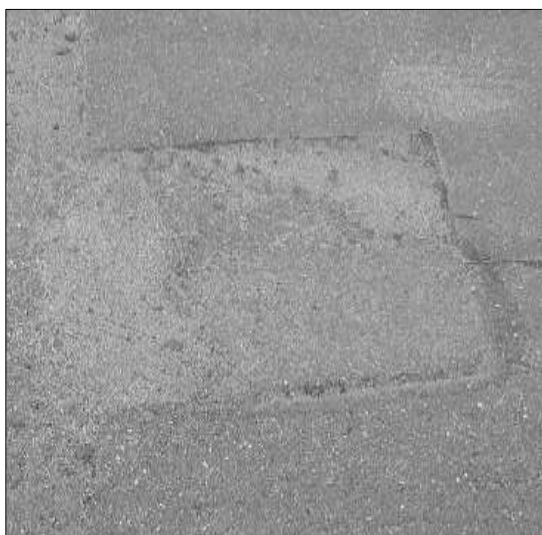
Рис. 5. Состояние ремонтной зоны сразу после ремонта 10.09.24 ( a ) и через 1 мес. после ремонта 09.10.24 ( б )
