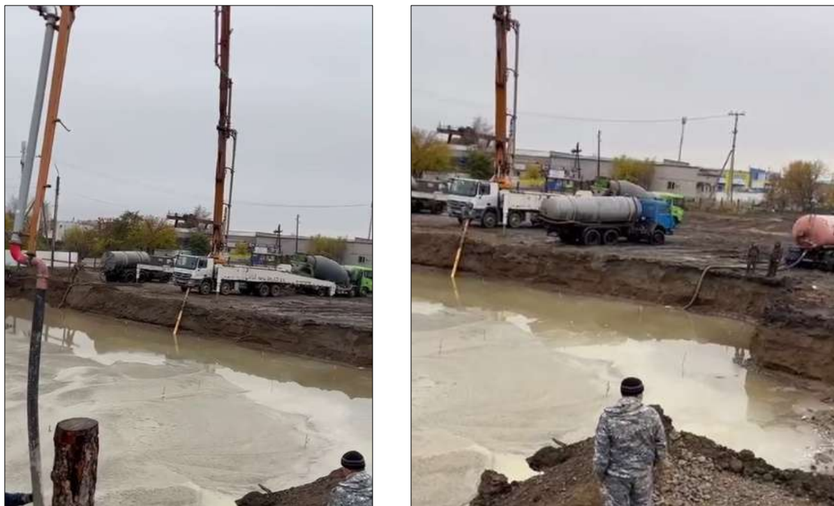
Рис. 4. Подводное бетонирование строящегося многоквартирного дома в Абакане на перекрёстке улиц Кирова и Богдана Хмельницкого
