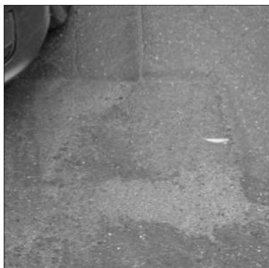
Рис. 6. Изменение ремонтной зоны через 1 мес. после ремонта 04.10.22 ( a ), через 4 мес. 24.01.23 ( б ), через 12 мес. 28.09.23 ( в ), через 26 мес. 10.10.24 ( г )
