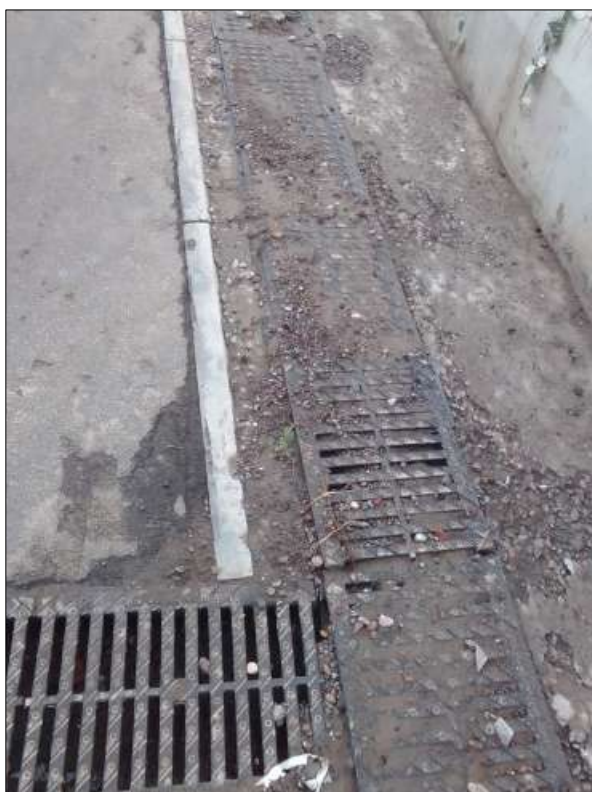
Рис. 4. Водоотводные лотки на улицах, примыкающих к Николаевскому пр. Июль 2024 г.
