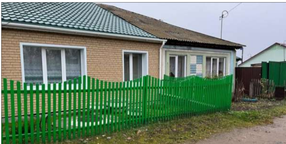
Рис. 1. 2-кв. дом, построенный по методу организованного замачивания грунта
