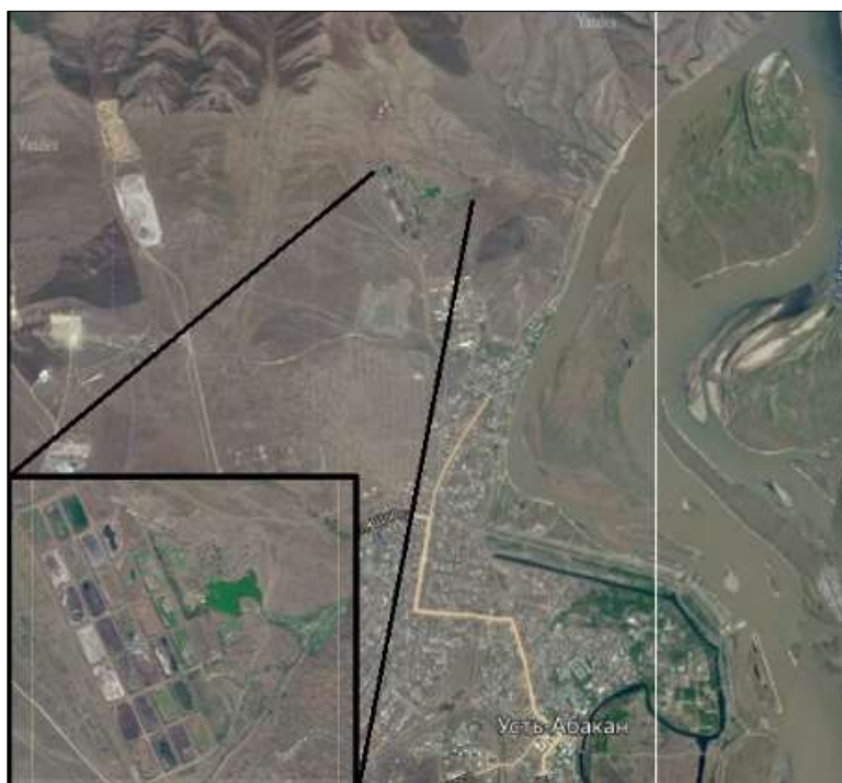
Рис. 2. Полигон с лигнином в Усть-Абакане. Вид со спутника
