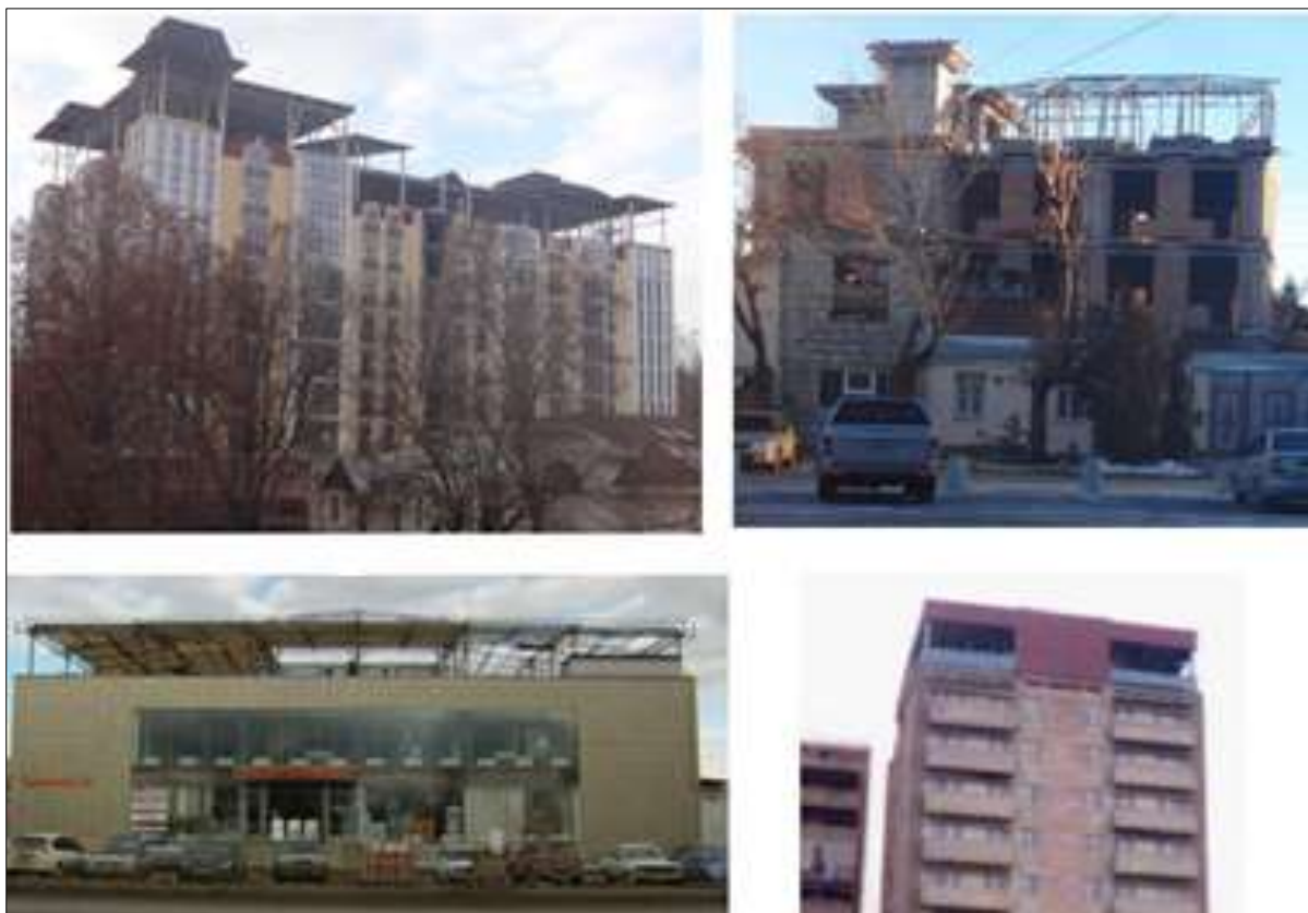
Рис. 2. Примеры зданий с гибкими верхними этажами
