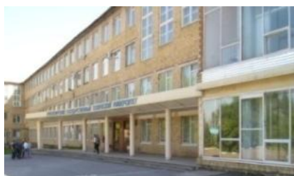
Политехнический институт (корпус «Д», ул. Академика Киренского, 26).
