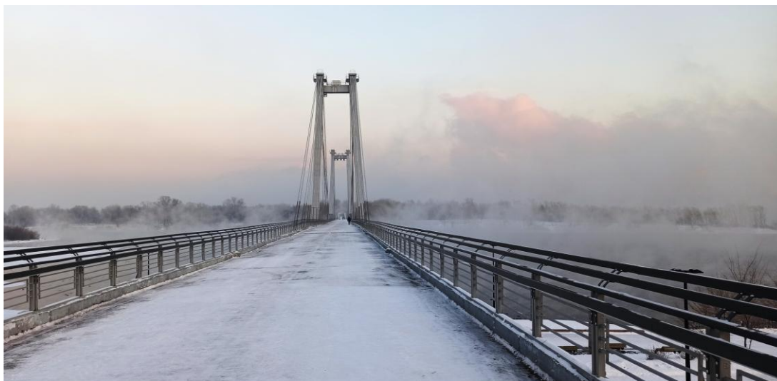
Красноярск. Мост на остров Татышева. Фото Л. Коневой.
