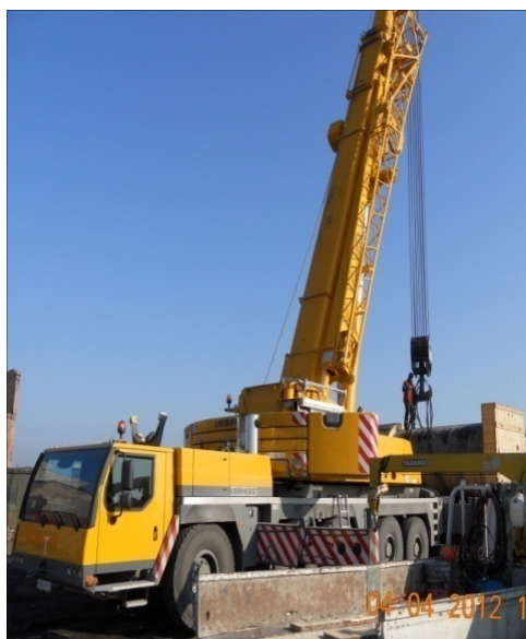
Рис. 2. Мобильный автокран Liebherr LTM 1130
