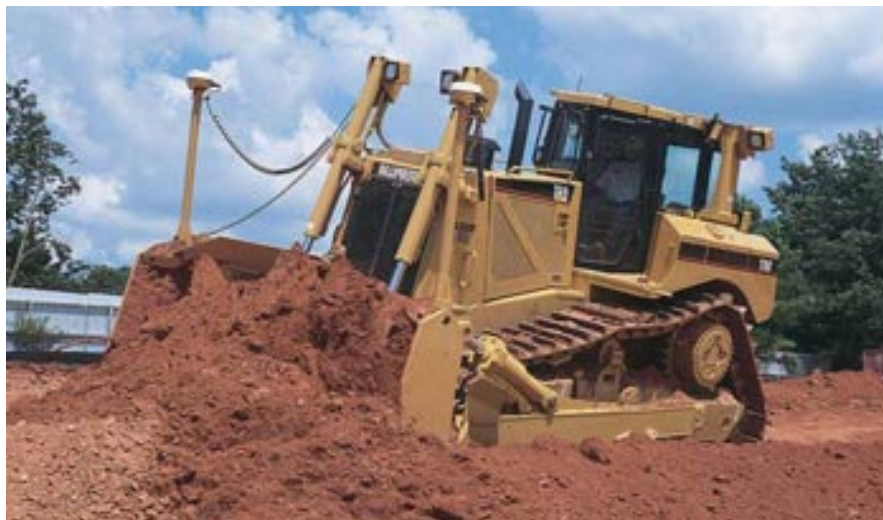
Рис. Бульдозер с трехмерной системой нивелирования
