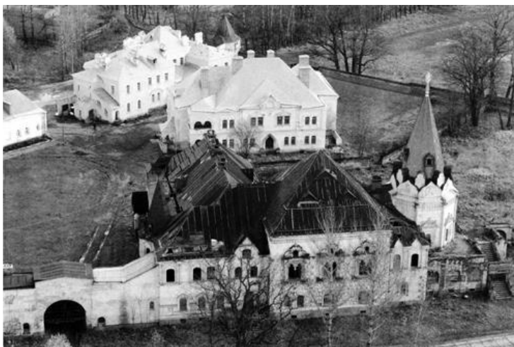
Рис. 3. Экстерьер Феодоровского городка
