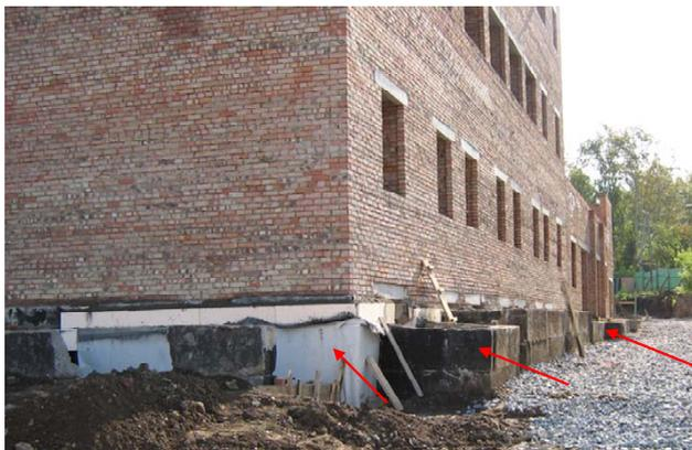
*Рис. 7. Вид на входы в подвал и прямки по оси Г (существенные отклонения по вертикали и горизонтали блоков стен, обусловленные просадкой основания из-за отсутствия должного уплотнения грунта)*
