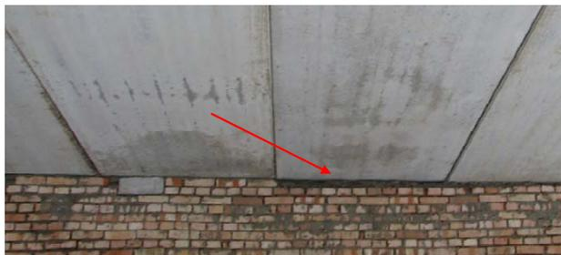
*Рис. 6. Вид опирания плит на кирпичную стену (имеет место из-за просадки колонн отклонение плит по горизонту этажа)*
