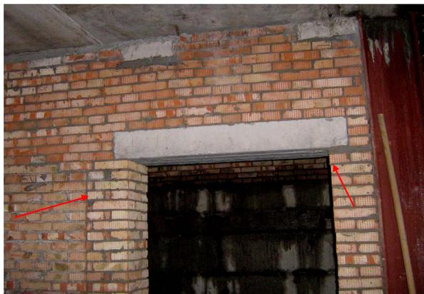
*Рис. 5. Вид проёма в кирпичной стене по оси 8, Б-В, на отм. -1.45 м (глубина опирания несущих перемычек – не более 110 мм, по проекту должно быть 235 мм; кладка с левой стороны проёма не имеет должной перевязки с остальной стеной)*
