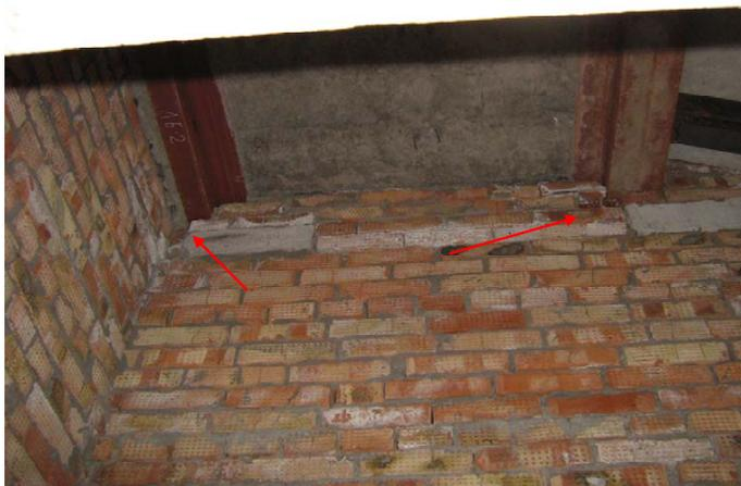
*Рис. 3. Вид снизу на место опирания балок лестничной клетки на отм. 0.00 на стену в осях 11-12 (отклонение отметок поверхностей, служащих опорами других элементов, на 65 мм)*
