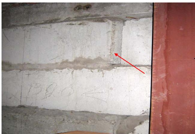
*Рис. 8. Вид на стену подвала по оси Б, 10 (видны смещения блоков по вертикали, до 55 мм)*
