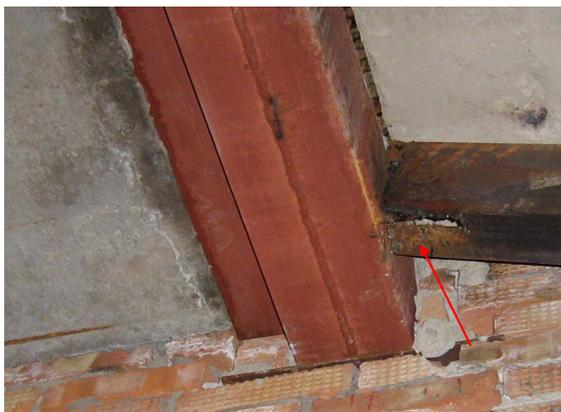
*Рис. 4. Вид снизу на узел сопряжения косоура (швеллера) с коробчатой балкой лестничной клетки в осях осей Б-Г, 11 на отм. +2.10 м (видны прожоги, наплывы, подрезы швов глубиной более 1 мм)*
